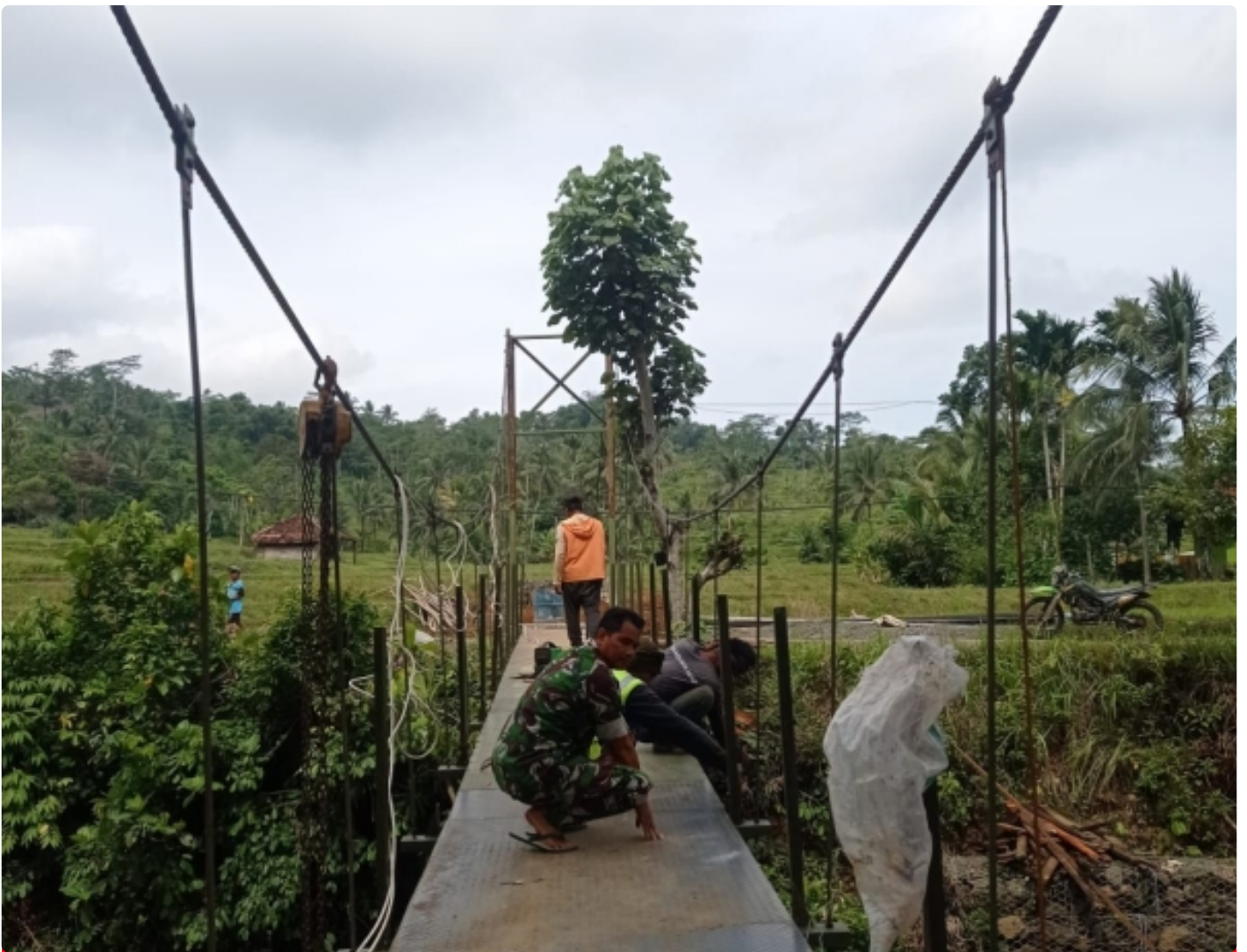
Kpt Arm Witono: Pengerjaan Jembatan Gantung Sudah 80%
